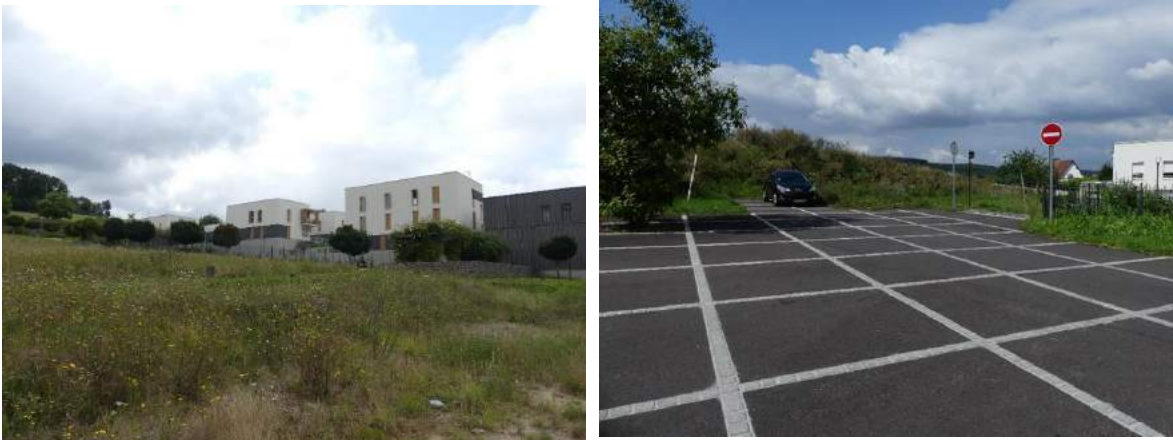
Figure 21 : Bâtiments de la gendarmerie, parking imperméabilisé, ARP-Astrance 2021
